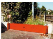
*Barrière manuelle. Serrage manuel par verin aux extrémités.
